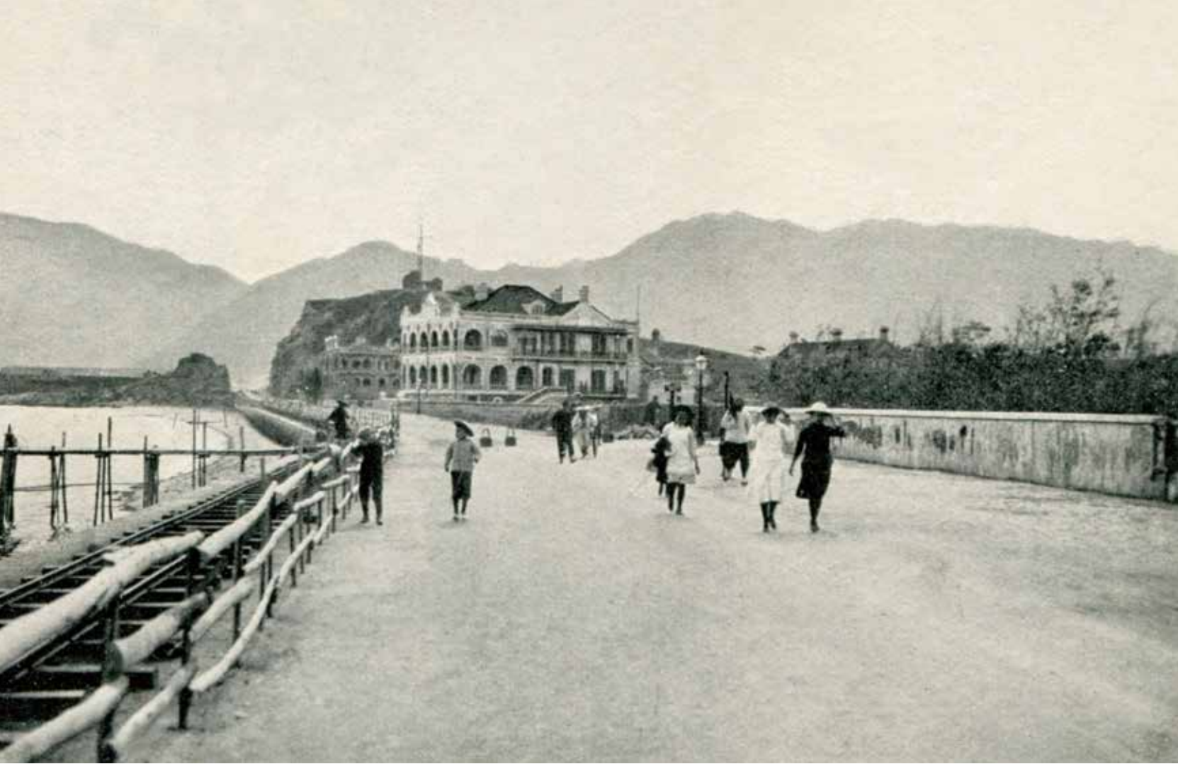
在尖沙咀漆咸道旁修建了臨時的窄軌路軌，以方便工程車把土方石運往填海地點。（攝於 1906 年）
