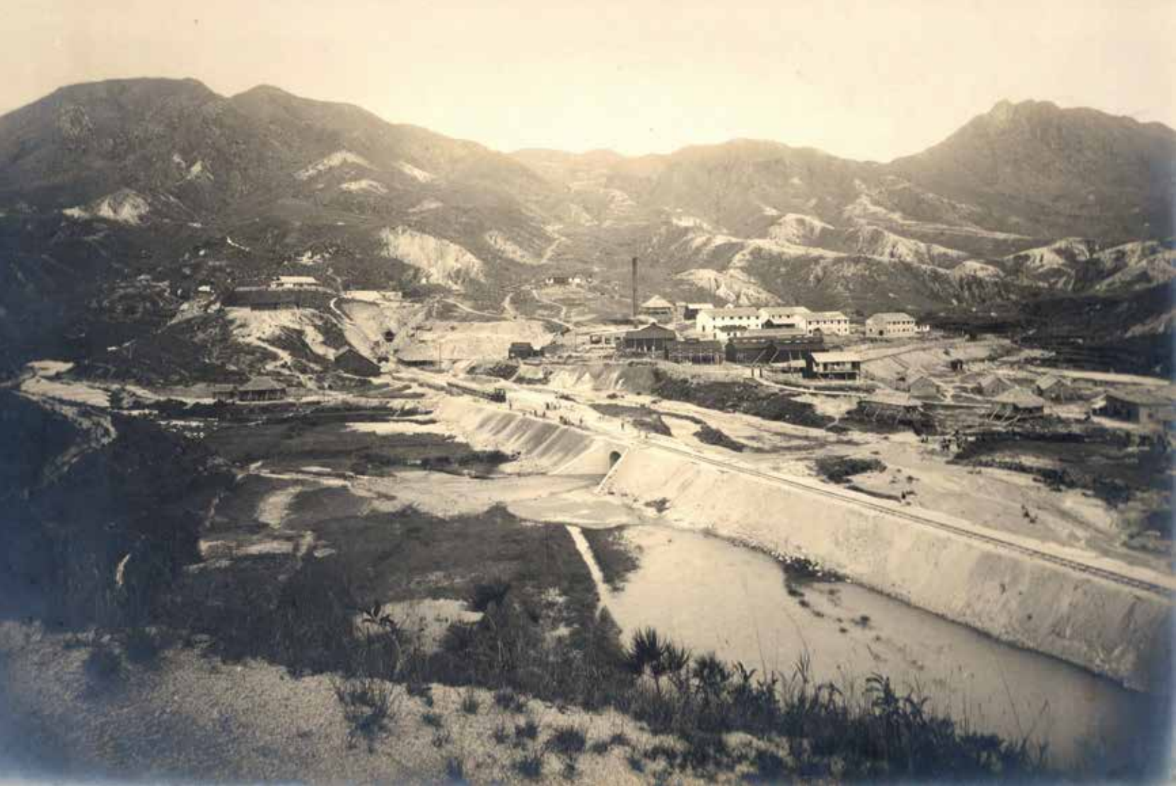
1907 年，鳥瞰筆架山隧道南面入口的施工情形，左面小山丘上的房屋是工程師們的宿舍。
