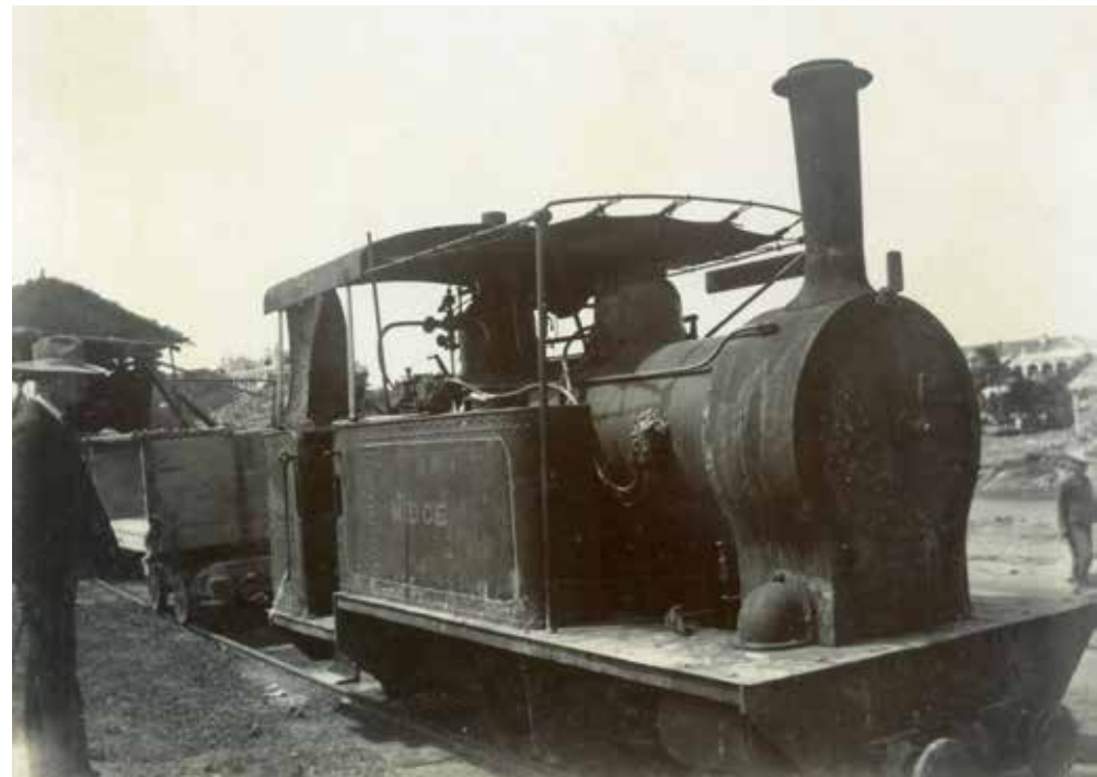
運送土方沙石的窄軌蒸汽小火車頭有 MIDCE 字樣，說明這些機車是來自馬來聯邦鐵路局中央工程部。（攝於 1906 年）
