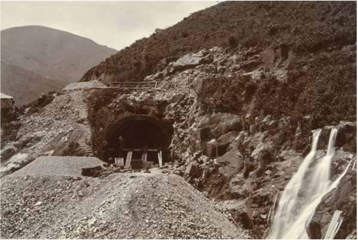
位於沙田和大埔間之第 3 號隧道正在開鑿，旁邊的馬尿河就是造成 1931 年火車出軌事故的元兇。
