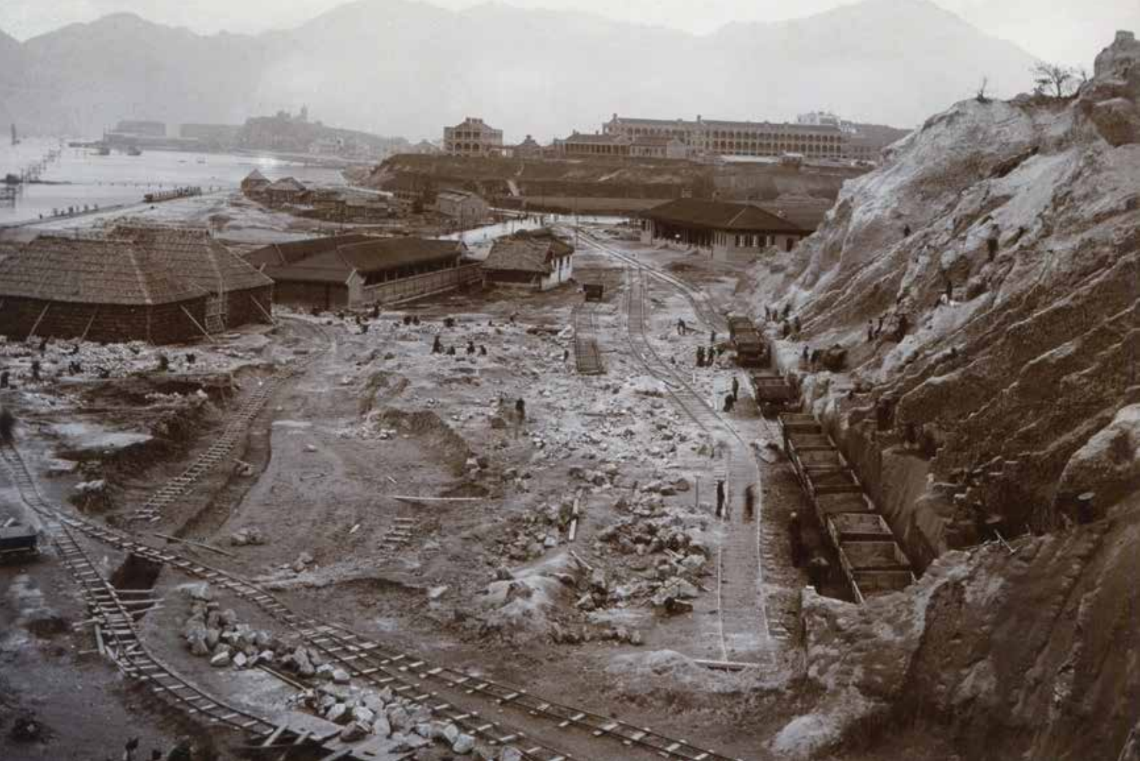
1906 年，窄軌蒸汽小火車正把土方泥石運往尖沙咀填海區。
