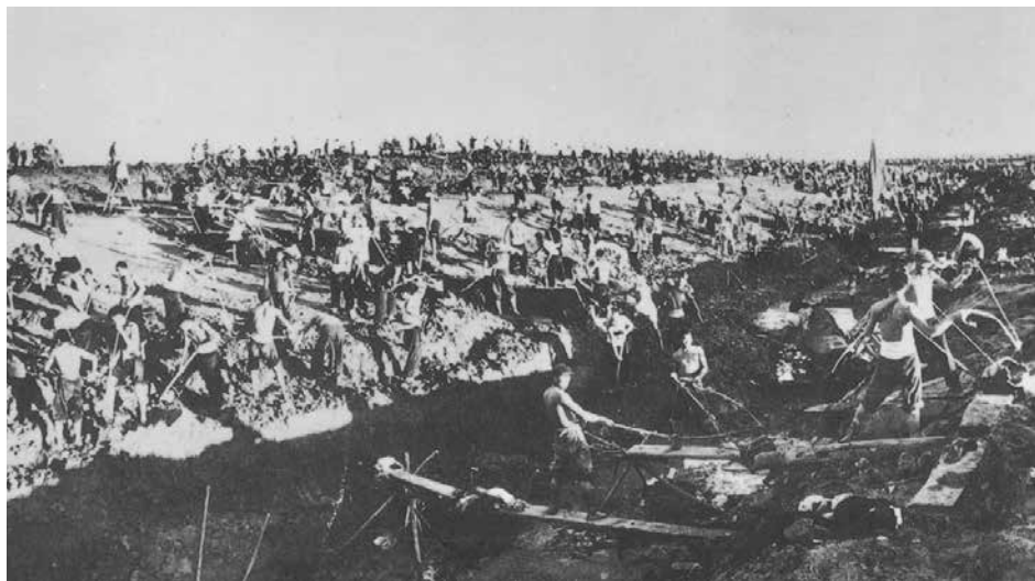
1957年冬至1958年春，河南鄭州市郊的引黃濟衛工程。當時，全國各地農村都掀起了群眾性的農田水利建設高潮。
