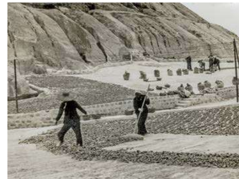
▲ 圖 31-4 茶果嶺高嶺土礦場的工作情況：工人將儲蓄池中沉積的黏土按粗幼分類。
