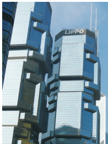
力寶中心由美國的 Paul Rudolph 設計，他最擅長凹凸的立面處理。
